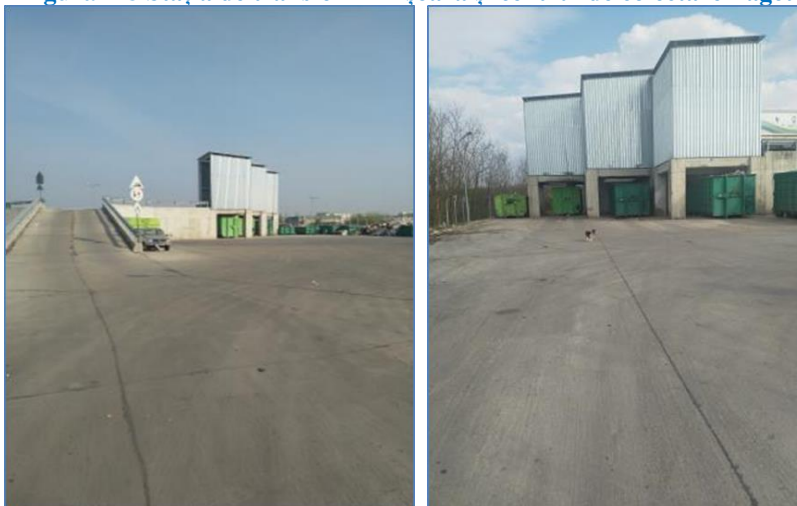
Figura 4-8 Stația de transfer Timișoara și centrul de colectare Făget
