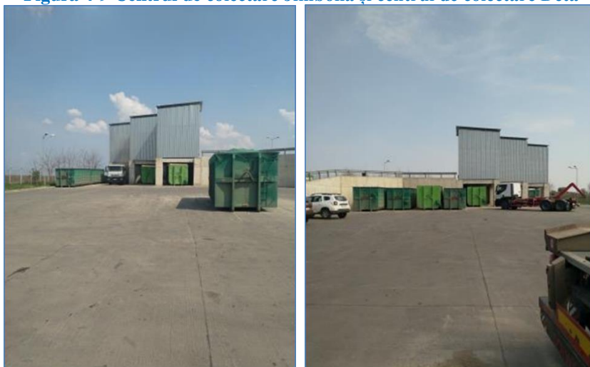
Figura 4-9 Centrul de colectare Jimbolia și centrul de colectare Deta
